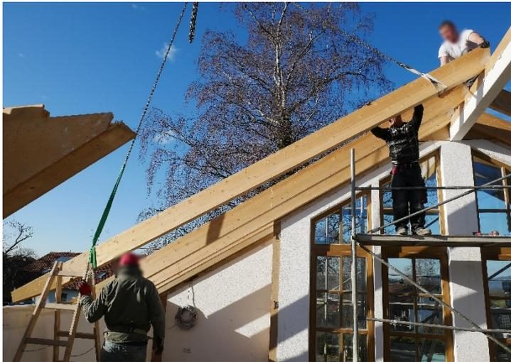
Abbildung 85: Montage der Dachsparren (eigene Darstellung)
