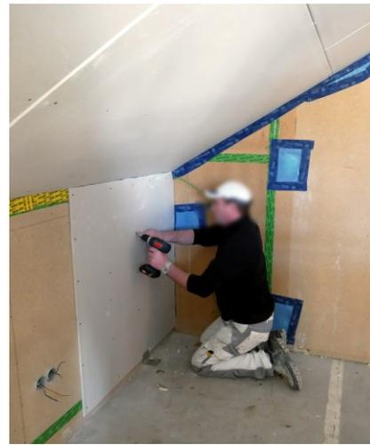
Abbildung 80: Anbringen der Gipskartonverkleidung (eigene Darstellung)
