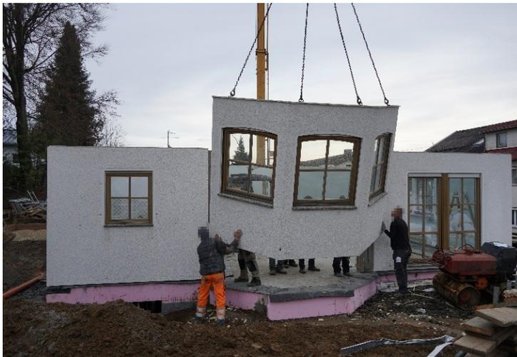
Abbildung 79: Aufbau der Wandelemente (eigene Darstellung)
