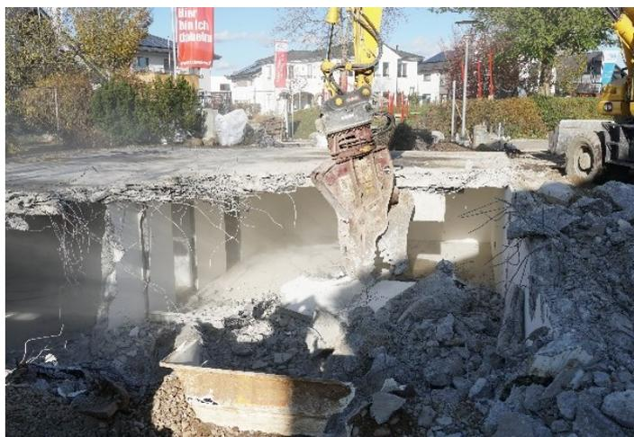
Abbildung 88: Zertrümmern des Gussasphaltestrichs (eigene Darstellung)
