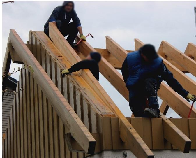
Abbildung 83: Demontage der Dachsparren (eigene Darstellung)
