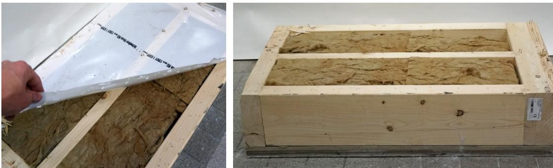
Abbildung 104: Trennung der PE-Folie vom Holzständerwerk (eigene Darstellung)
