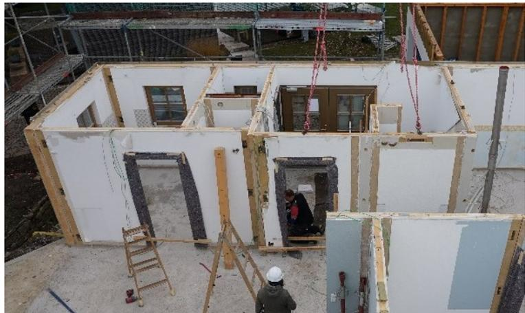
Abbildung 76: Freilegung der Verschraubungen zwischen Wänden (eigene Darstellung)
