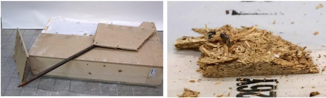
Abbildung 103: Trennung der Spanplatte vom Holzständerwerk (eigene Darstellung)
