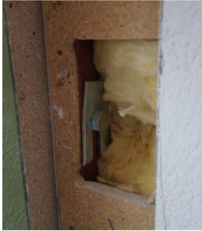
Abbildung 97: Verschraubung Wand/Wand (eigene Darstellung)
