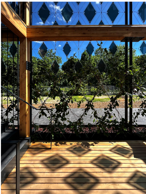
Kombination von PV-Elementen und Altholzfassade
