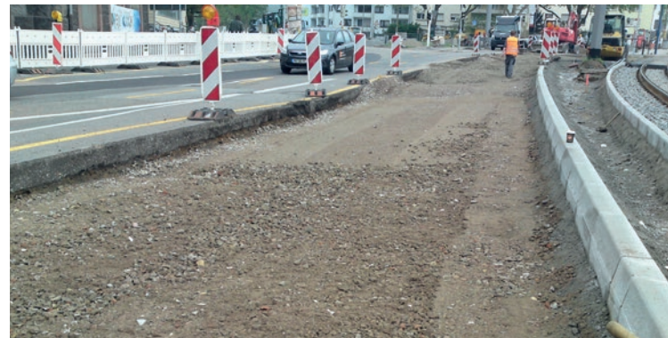
Qualifizierte güteüberwachte Frostschutzschicht aus dem Materialkreislauf, eingebaut
