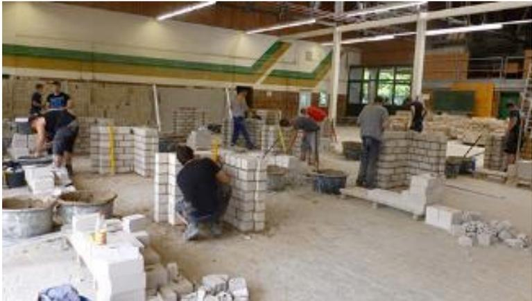
Ermittlung des Rückbauaufwands und der Sortenreinheit in Versuchsständen
