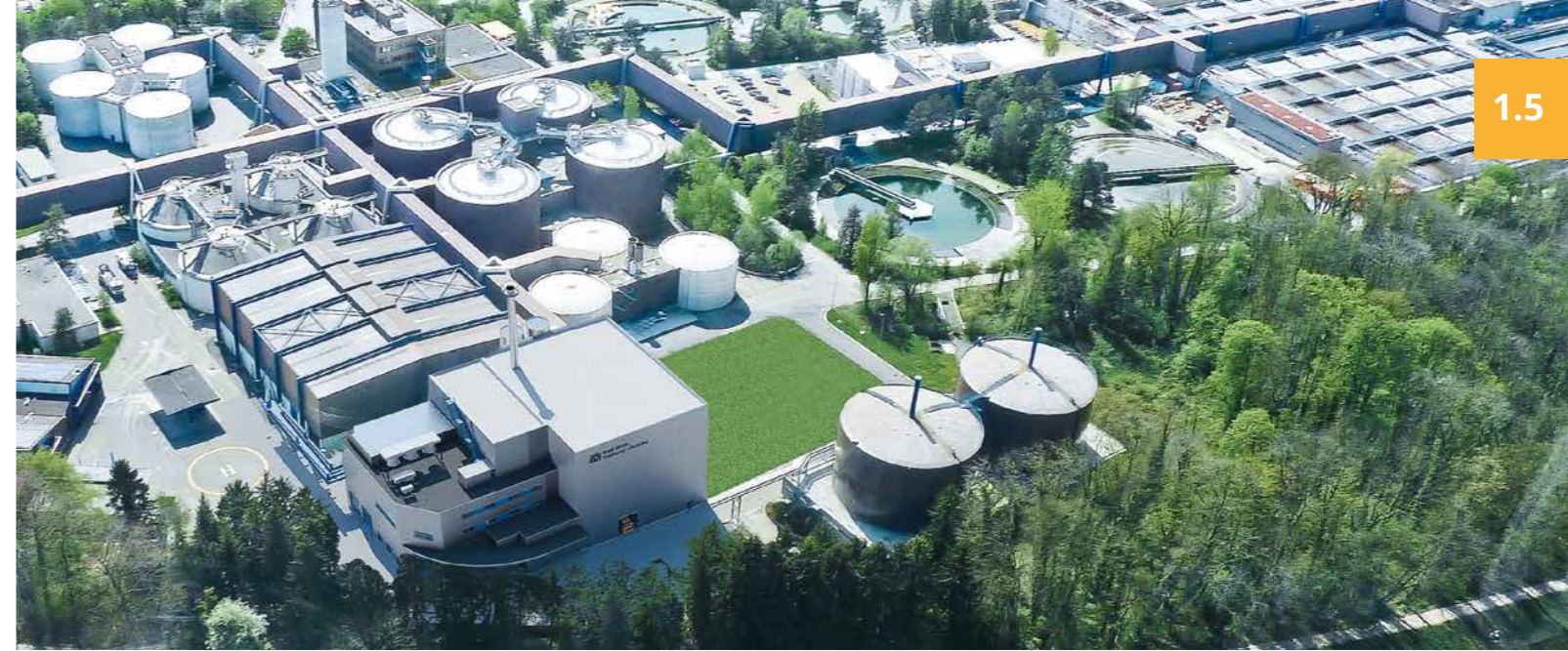
Monoklärschlammverbrennungsanlage in der Schweiz, Quelle: TBF
