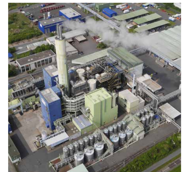
Sonderabfallverbrennungsanlage mit Lagertanks, Quelle: HIM
