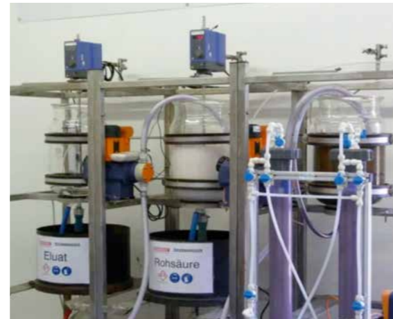
Phosphorrückgewinnung aus Klärschlamm, Technikumsanlage der Eurawasser Nord GmbH in Rostock. Quelle: Remondis
