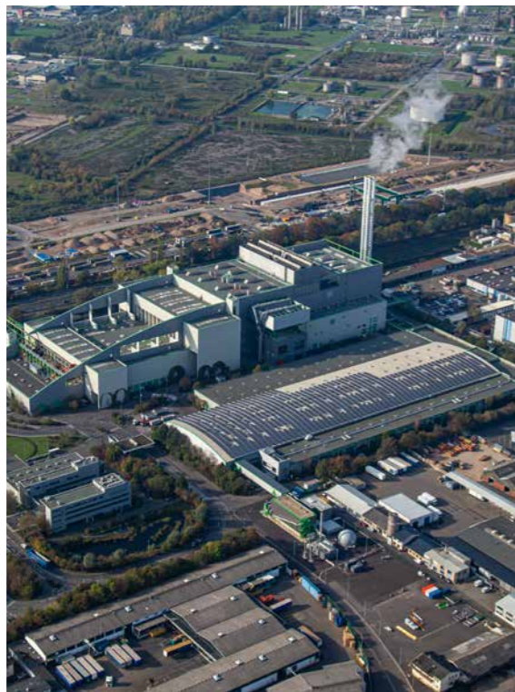
Müllverbrennungsanlage, Quelle: AVG Köln
