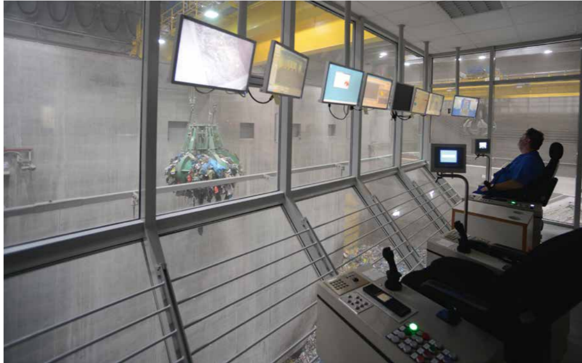
Müllheizkraftwerk Krankanzel, Quelle: BSR
