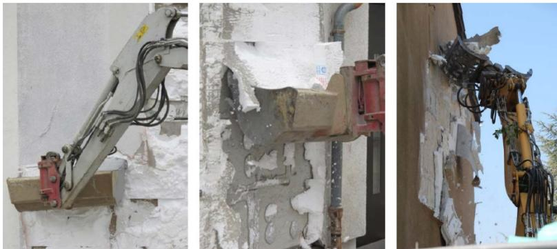
Abbildung 7: Selektives Abschälen der einzelnen Lagen eines WDVS. Oberputz (links), Dämmstoff (Mitte) und teilweise selektives Abschälen in der Praxis (rechts)<sup>141</sup>
