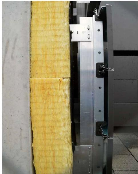
**Abbildung 4:** Eine Aluminiumkassette mit Clipverbindung auf verschraubter Alu-Unterkonstruktion als Beispiel für eine demontierbare und recyclingfähige Fassade<sup>90</sup>
