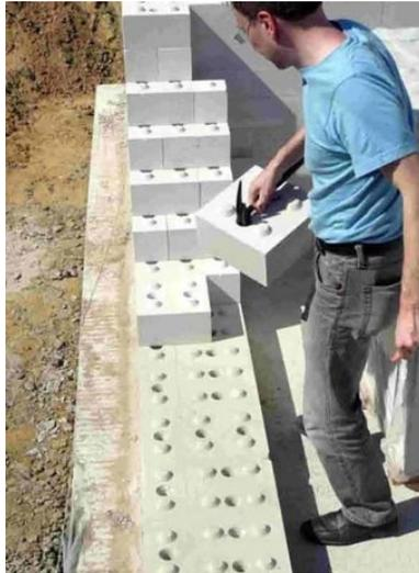
Abbildung 5: Das im Forschungsprojekt „ReMoMaB“ entwickelte mörtellose Mauerwerk<sup>100</sup>
