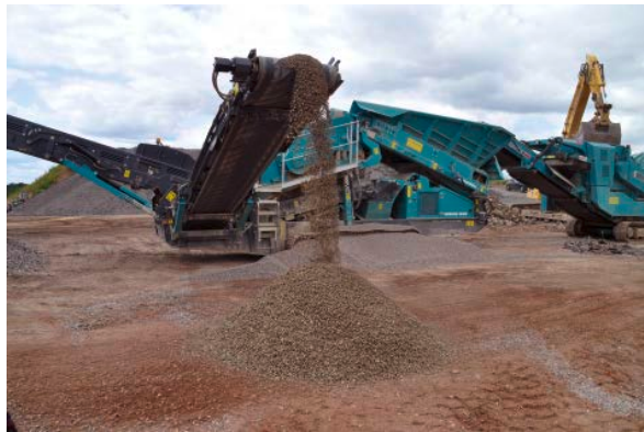
Abbildung 4 Betonabbruch aus den Decken, Unterzügen und Stützen des Bestandsgebäudes wird zu rezyklierbarer Gesteinskörn
