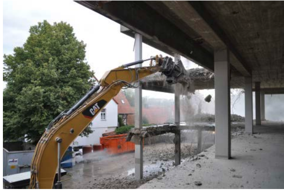
Abbildung 3 Abrissarbeiten an der nicht sanierungswürdigen Rathäuserweiterung im Sommer 2019; Quelle ARGE agn-heimspiel
